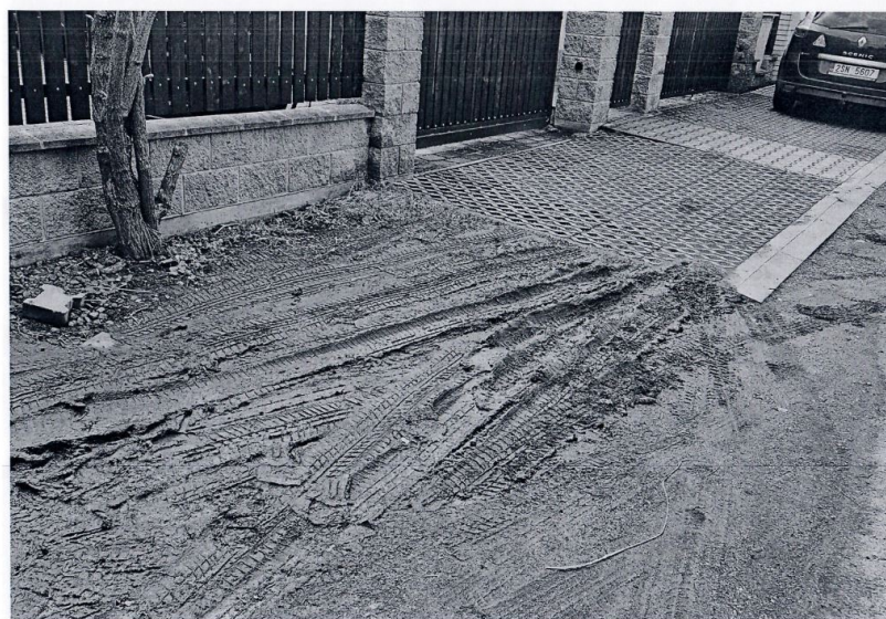
Obr. 2 – stav před č.p. 417, Březiněveská ulice v březnu 2024 (zdroj: žádost)
